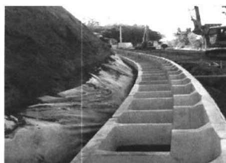
Рисунок 14 - Установка по кривой.
