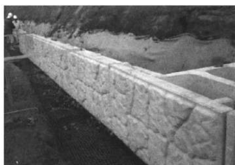
Рисунок 13 - Работы по заделке краев нижнего ряда.
