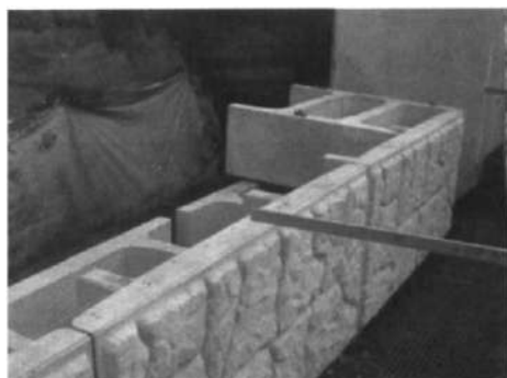
Рисунок 21 - Вид заделанного торца ряда блоков.
