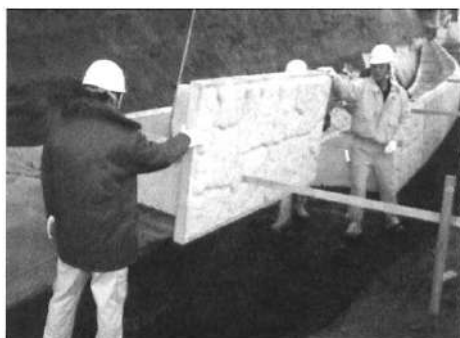
Рисунок 11 - Установка нижнего ряда
