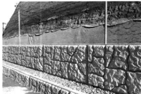
Рисунок 18 - Установка второго ряда.
