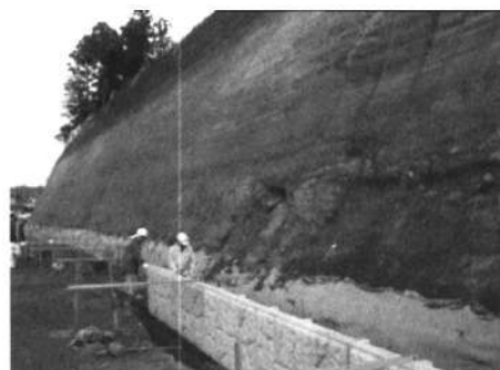
Рисунок 12 - Установка нижнего ряда
