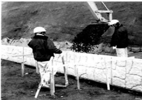
Рисунок 15 - Засыпка заполнителя
