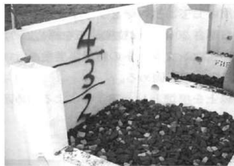
Рисунок 16 - Выровненный слой щебня внутреннего заполнения.
