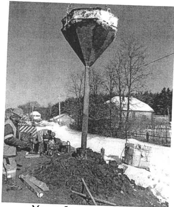
Монтаж бетонолитной трубы
