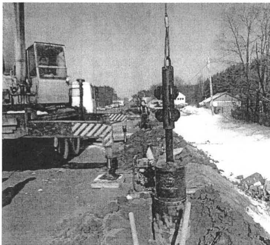
Извлечение долота из полого шнека
