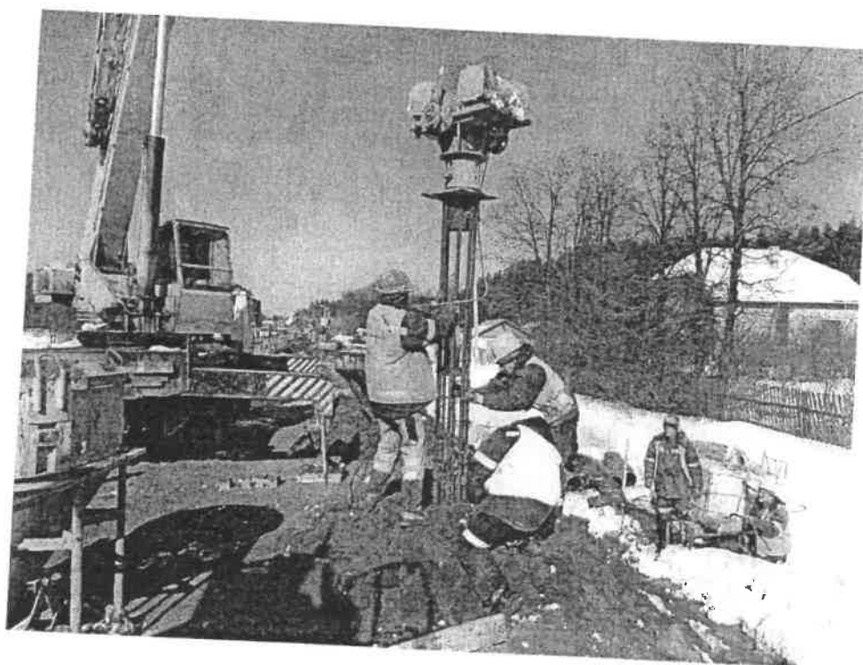
Погружение каркаса в заполненную бетонной смесью скважину
