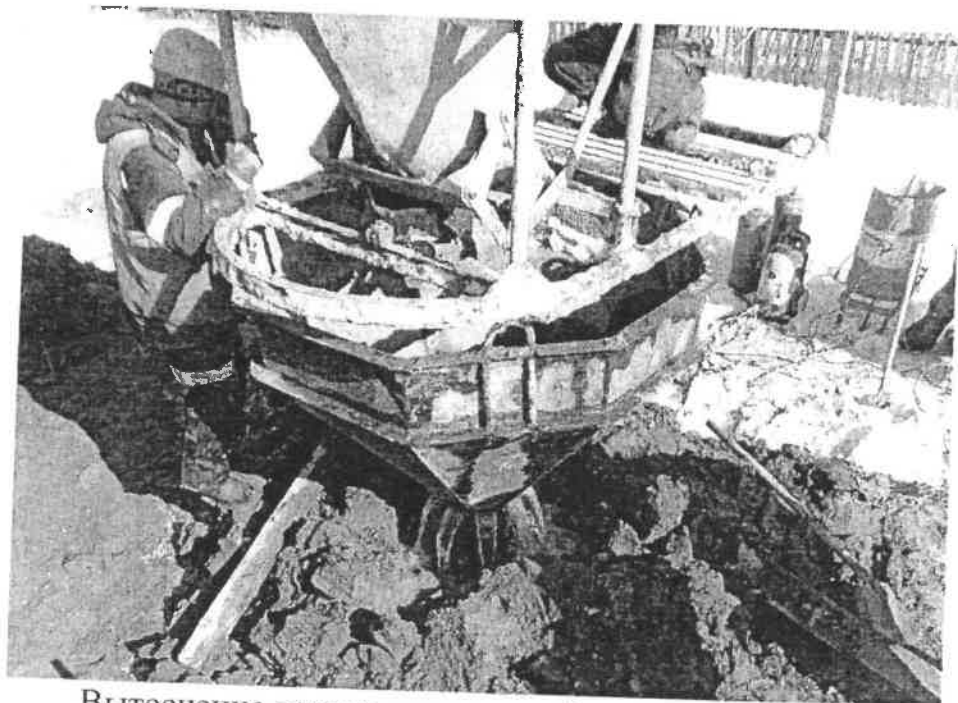
Монтаж бетонолитной трубы
