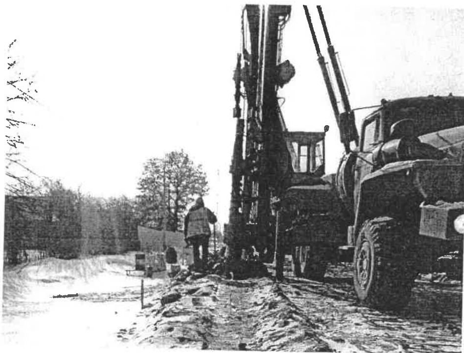
Бурение скважины до проектной отметки
