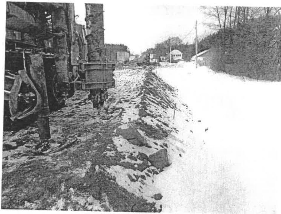
Установка буровой машины на точку
