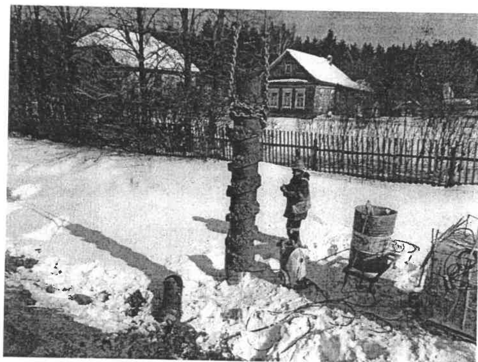
Очистка шнека от грунта
