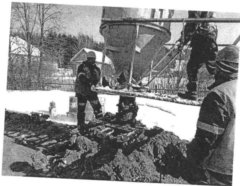
Долив бетонной смеси
