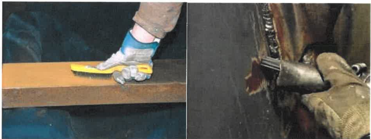
Рисунок 11 – Применение механического инструмента в ходе подготовке поверхности
