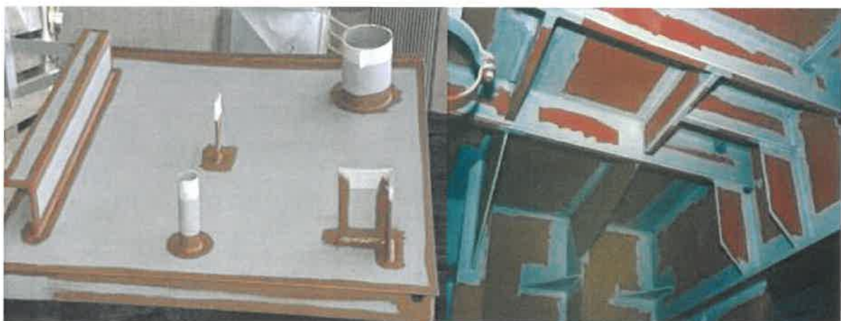
Рисунок 13 – Элементы конструкции после проведения полосовой окраски
