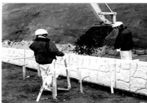
Рисунок 15 - Засыпка заполнителя
