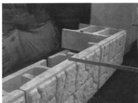
Рисунок 21 - Вид заделанного торца ряда блоков.
