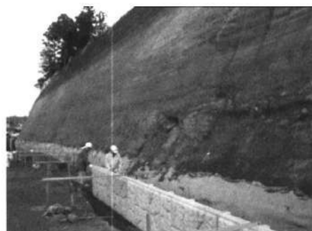
Рисунок 12 - Установка нижнего ряда
