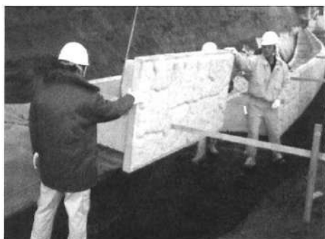
Рисунок 11 - Установка нижнего ряда
