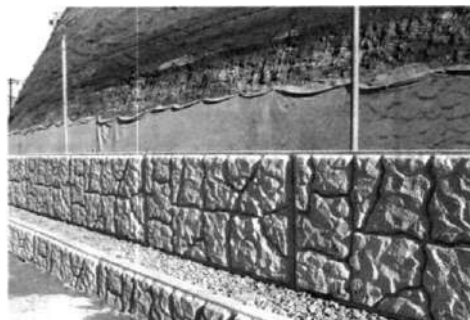
Рисунок 18 - Установка второго ряда.
