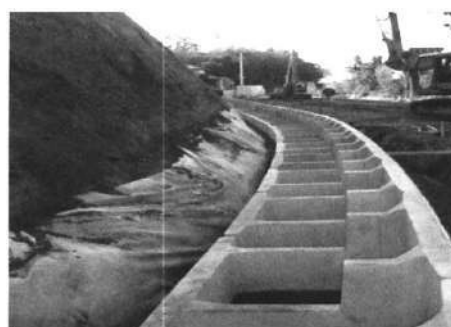
Рисунок 14 - Установка по кривой.
