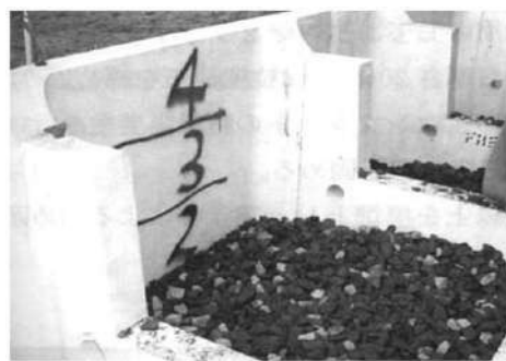
Рисунок 16 - Выровненный слой щебня внутреннего заполнения.
