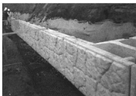
Рисунок 13 - Работы по заделке краев нижнего ряда.
