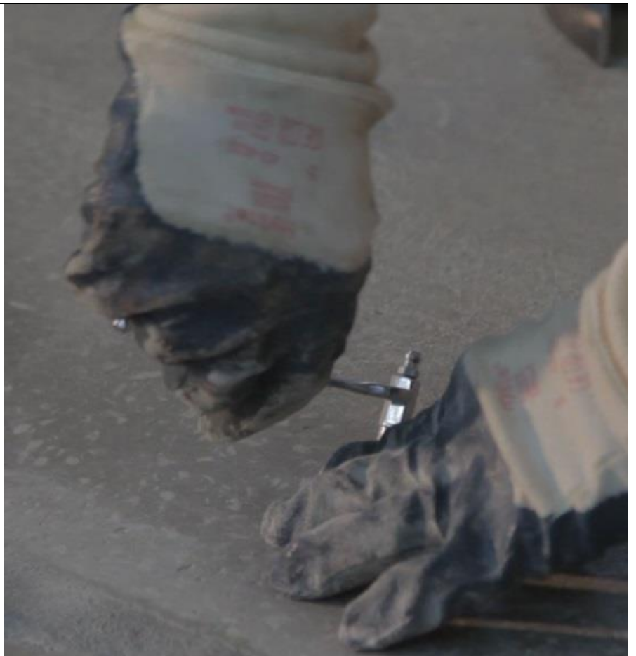
Рисунок 13.8 – Установка инъекторов
