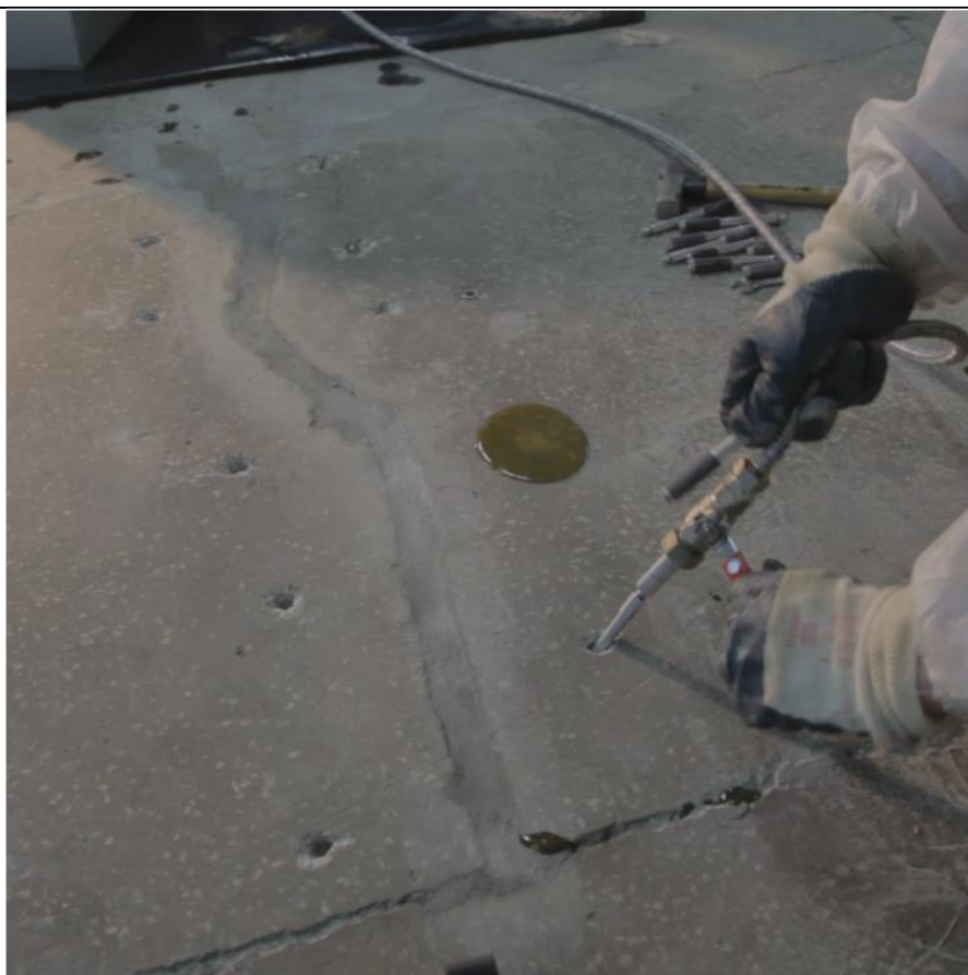
Рисунок 13.9 – Выполнение инъекционных работ
