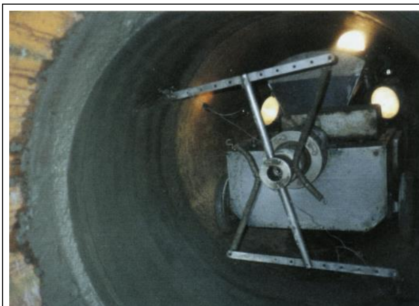
Нанесение защитного цементно-песчаного слоя
