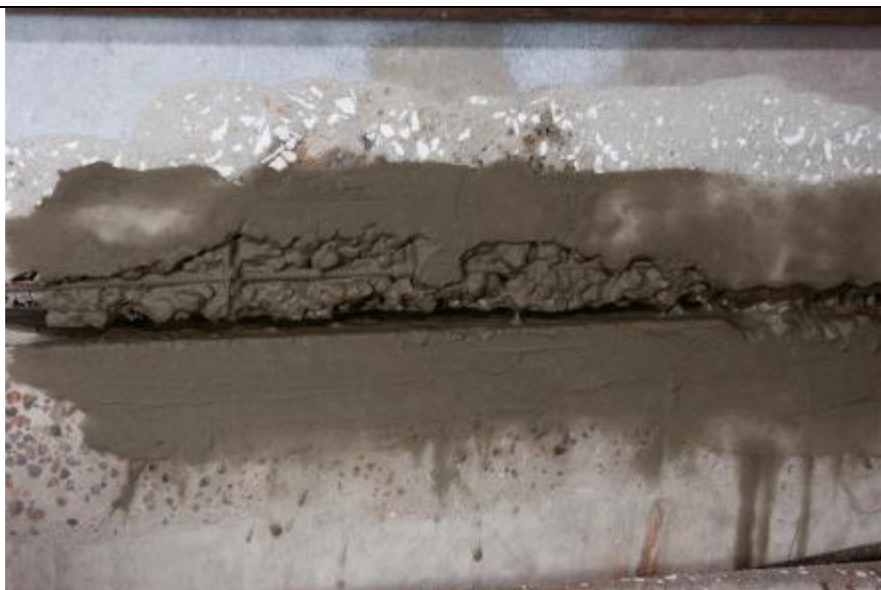
Рисунок 12.2 –Штраба, загрунтованная раствором смеси «Пенетрон»
