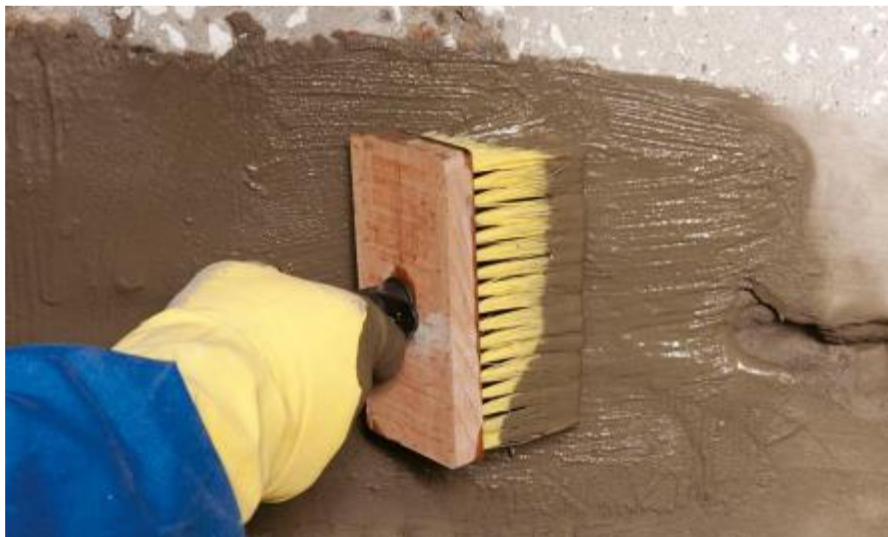
Рисунок 12.5 – Обработка штрабы смесью «Пенетрон» Принципиальные схемы гидроизоляции трещин и швов при наличии и отсутствии течей показаны на рисунках 12.6–12.9.
