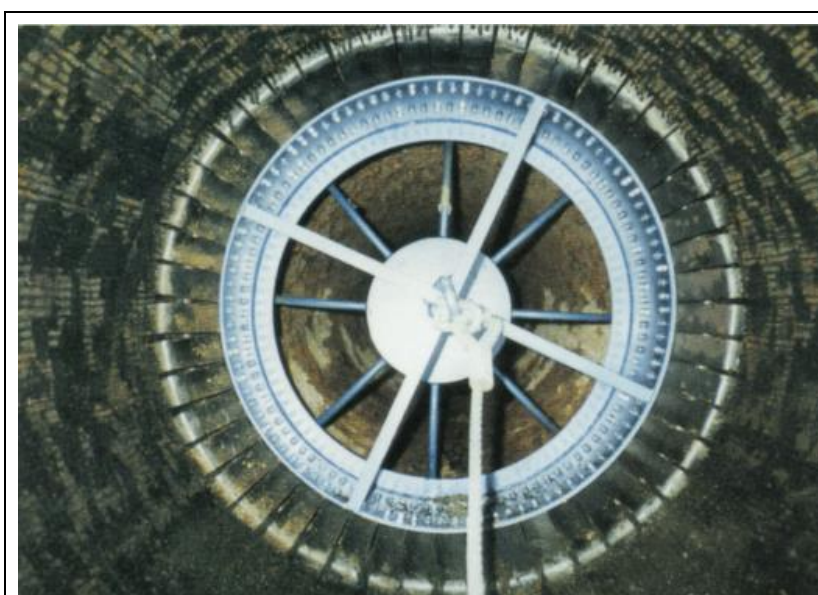
Очистка трубопровода
