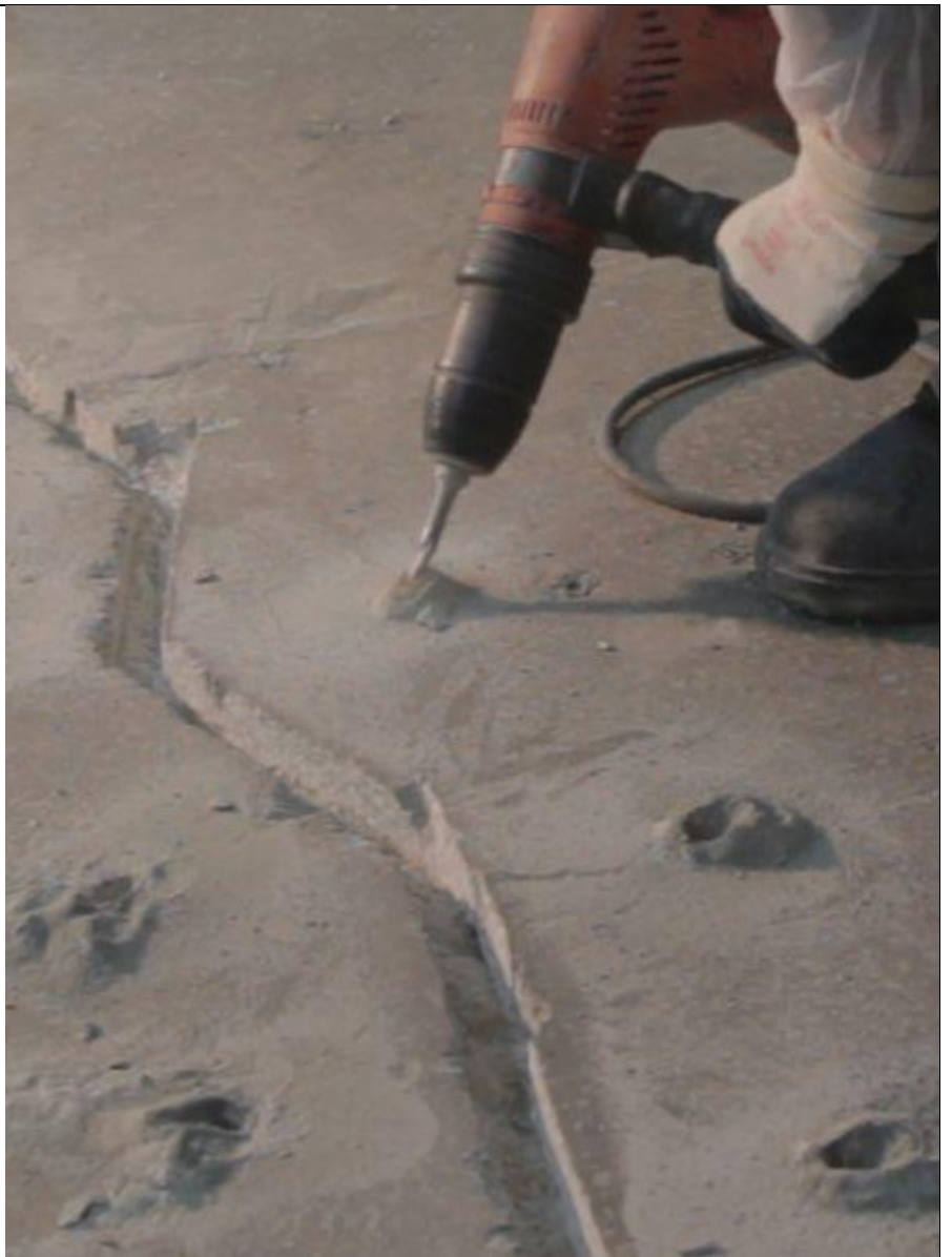
Рисунок 13.2 – Бурение отверстий для иньекторов
