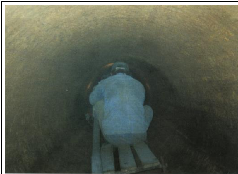
Оператор в трубопроводе за работой
