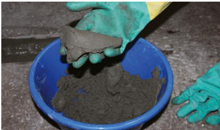
Рисунок 12.3 – Приготовление смеси «Пенекрит»
