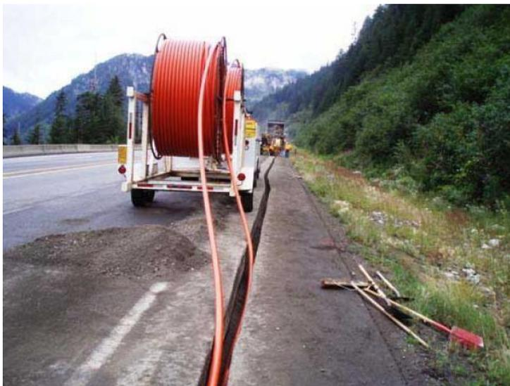
Рисунок 8 – Подача пакета микротрубок с кабельного транспортера
