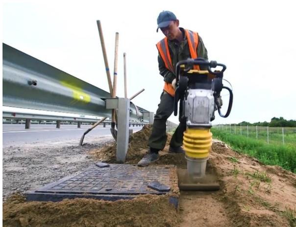
Рисунок 32 – Уплотнение грунта с применением вибротрамбовочного аппарата
