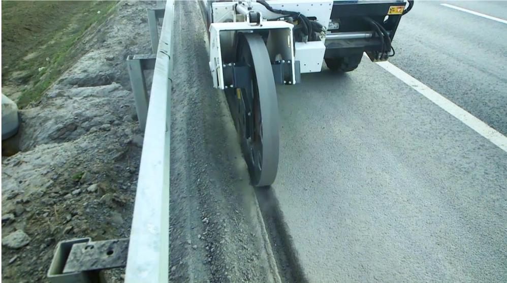
Рисунок 12 – Вибротрамбовочная техника на базе минипогрузчика
