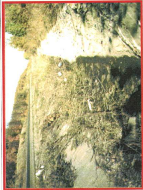
Не очищенная от мусора система водоотвода (водоотводные, прикромочные лотки, быстротоки, нагорные канавы и т.д.)
