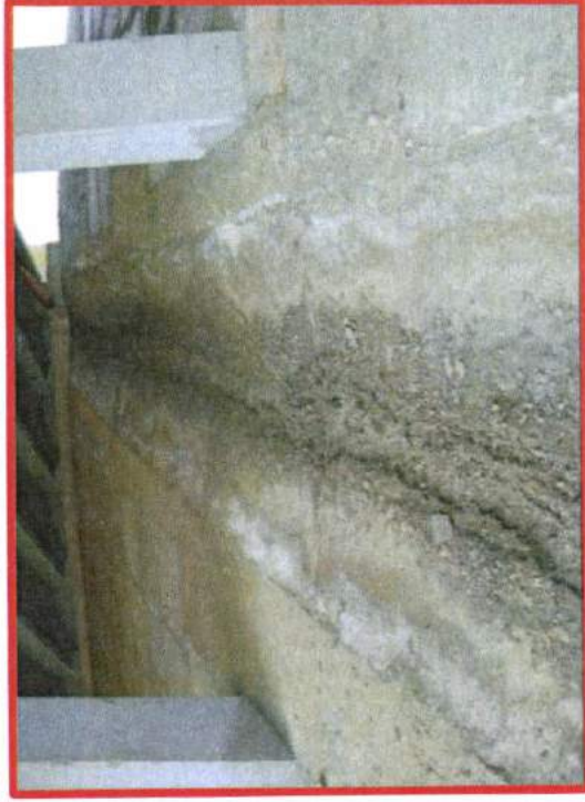
Не очищенная от мусора система водоотвода (водоотводные лотки, гасители и т.д.)
