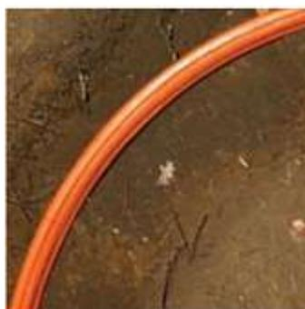
Рис. 4.1.3 Прокладка микротрубок при повороте траншеи
