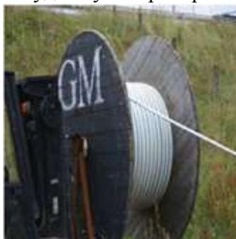
Рис. 4.1.1 Отмотка микротрубки с барабана
