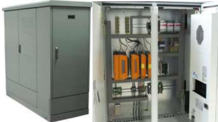
Рисунок 3.6 Общий вид (справа) и вид на оборудование (слева) ДКШ
